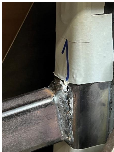
Figura 71- Junta após ensaio (Ensaio de flexão com junta instrumentada)
