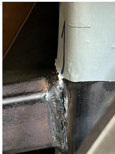
Figura 72- Fissura obtida durante o ensaio (Ensaio de flexão com junta instrumentada)
