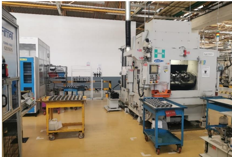
Figura 58 - Zona de instalação do pórtico
