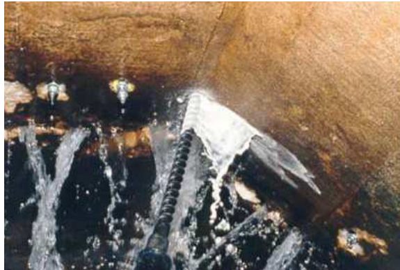
Figura 52 – Exemplo de injeção de argamassa em fissuras com infiltração de água (EPA, 2010)
