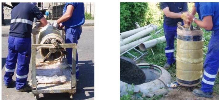
Figura 49 - Aplicação de reparação com remendo curado in situ (fonte: Águas de Gondomar, S.A.)
