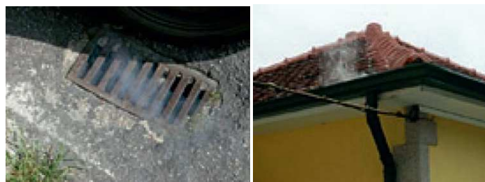
Figura 68 – Exemplos de aplicação de testes de fumo (ERSAR, 2010)
