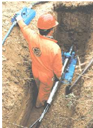
Figura 62 – Exemplo de Técnica com deslocamento do solo com sistema de impacto (EPA, 2010)
