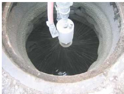
Figura 53 – Aplicação, por projecção, de cimento reforçado com fibra (EPA, 2010)
