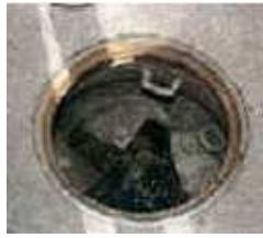
Limpeza da câmara de visita
