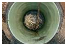
f) Colector rehabilitado
