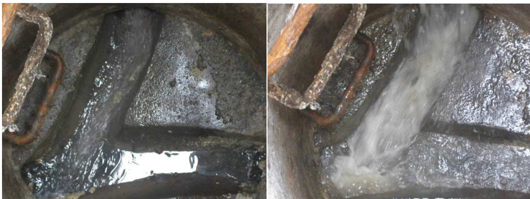
Figura 65 – Exemplo de câmara de visita com excesso de caudal em dia de precipitação intensa (fonte: Águas de Gondomar, S.A.)
