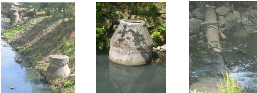
Figura 11 – Câmaras de Visita e Emissário no rio Tinto (fonte: Águas de Gondomar, S.A.).
