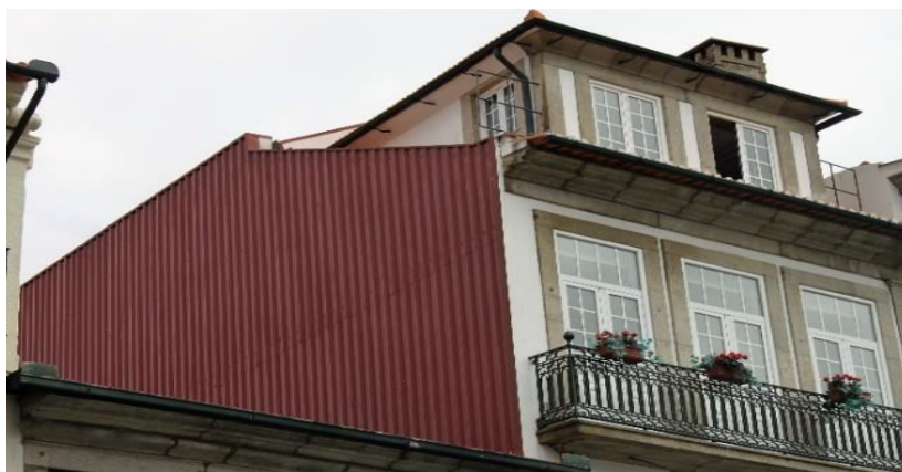
Figura 3.3 Paramento exterior revestido com chapa ondulada metálica (Autor).
