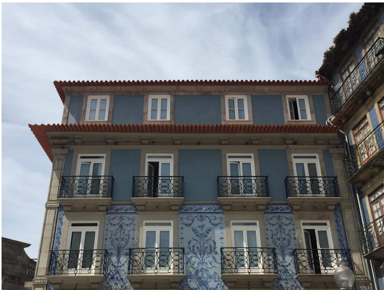
Figura 3.9 Janelas de peito batente e no último piso janelas de sacada de batente, situadas na rua das Flores (Autor).
