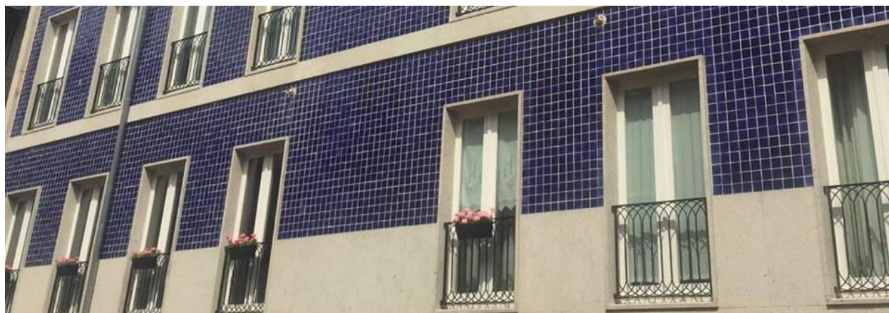
Figura 3.7 Grade de ferro de janelas no Porto (Autor).
