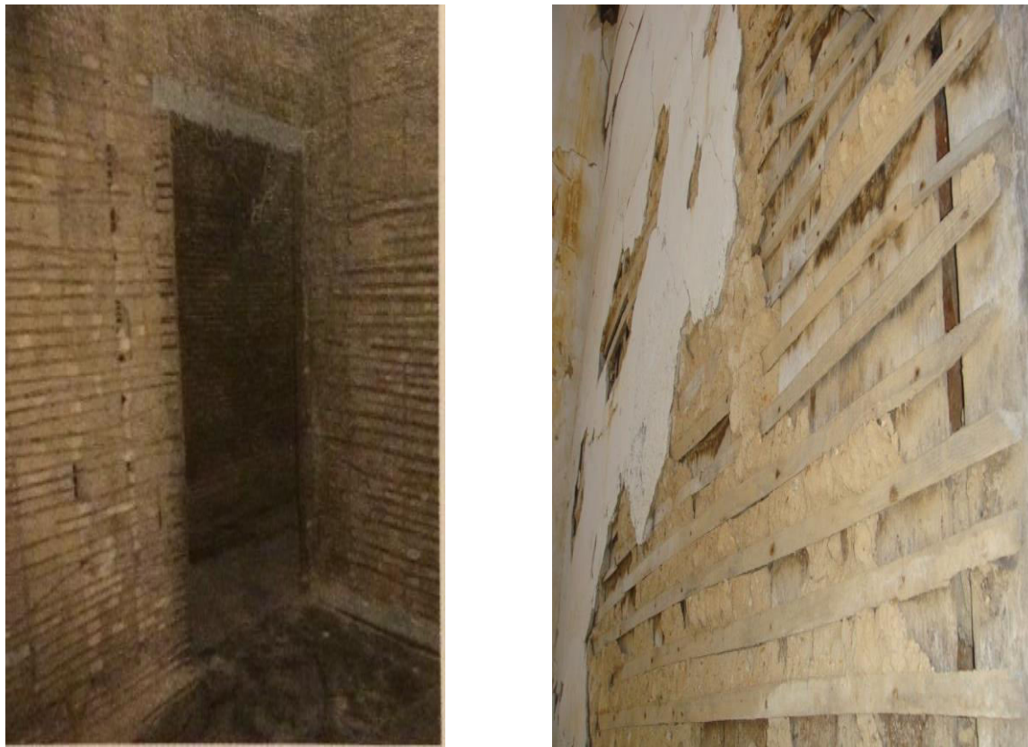
Figura 3.2 Parede de tabique
