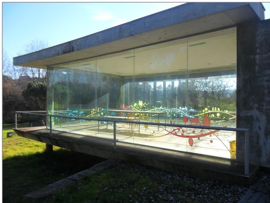
Fotografia 82: Centro de Educação Ambiental inativo; Parque da Ciência; 2019.
