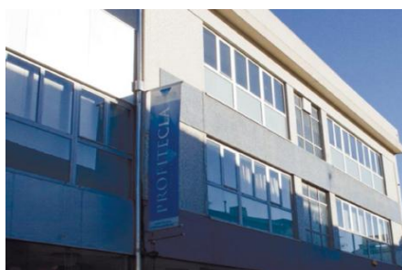
Figura 6 – Edifício da Profitecla – polo de Barcelos
