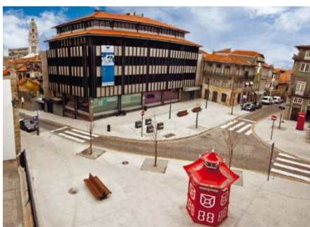
Figura 5 – Edifício da Profitecla – polo do Porto
