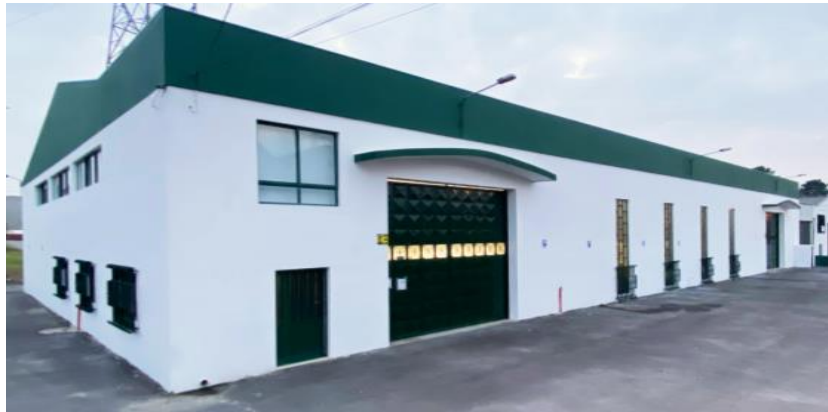
Figura 2 - Instalações da empresa Domprato
