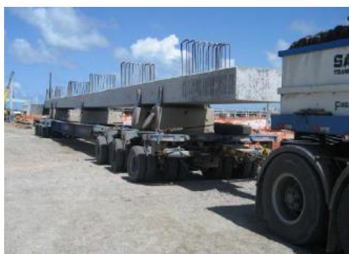
Figura 12 - Transporte de pilares com 35m de altura [20]
