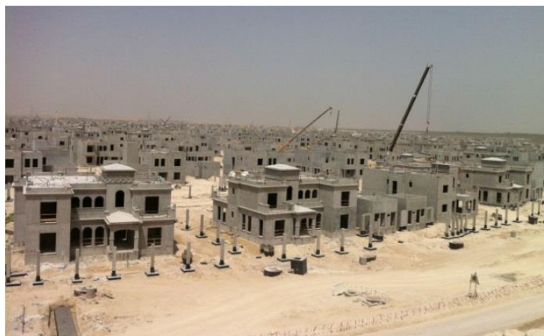
Figura 39 - Construção sequencial de 2000 moradias na área de Al Falah, Abu Dhabi, com recurso a sistemas de paredes resistentes [40]
