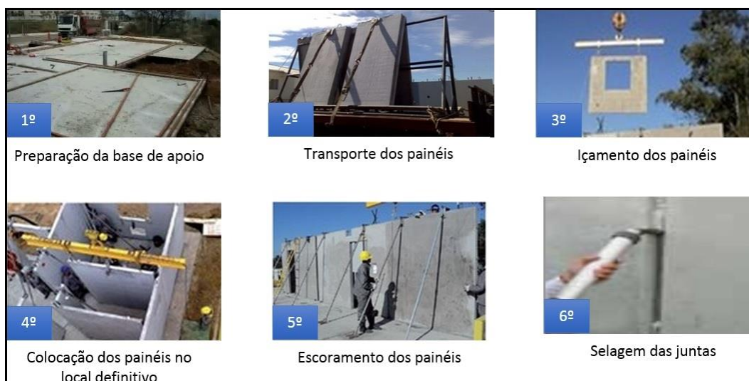
Figura 41 - Sequência de aplicação de painéis pré-fabricados (adaptado de [42]; [43])
