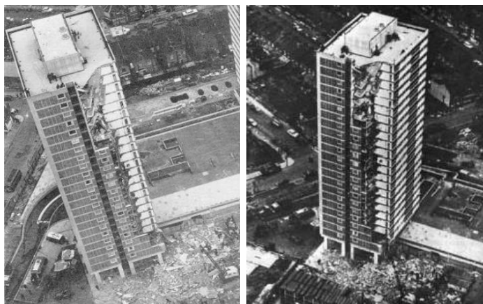
Figura 4 - Edifício “Ronan Point (explosão de gás no 18º andar gerou um colapso progressivo) [7]
