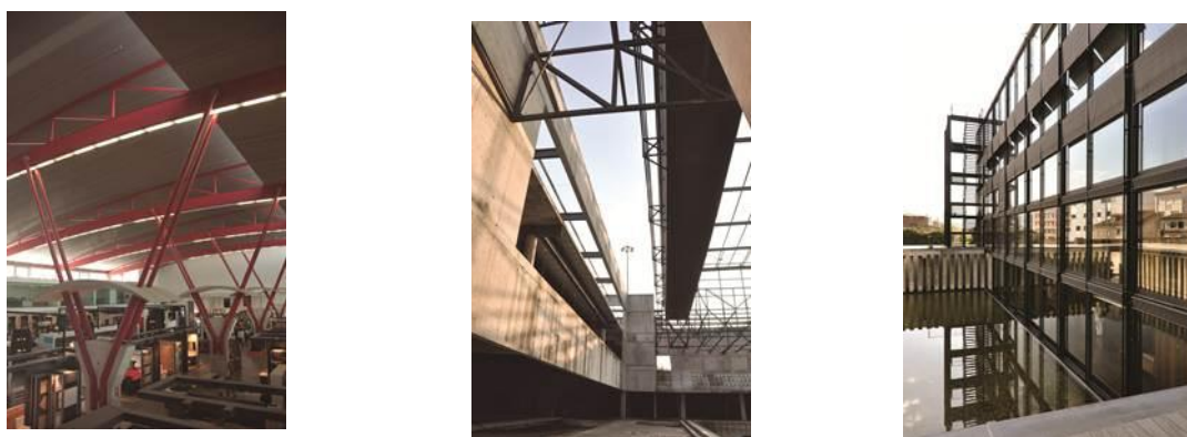
Figura 10 - Exemplos de algumas estruturas metálicas realizadas.
