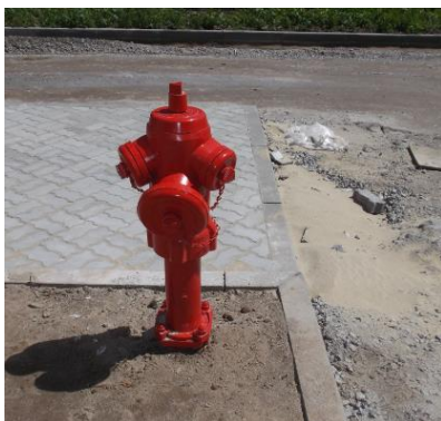
Figura 5.53 – Marco de incêndio
