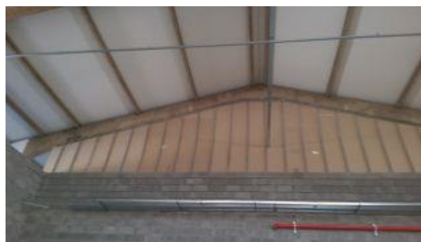
b) Montagem das placas de gesso cartonado ignífufo
