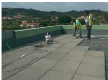
b) Placas de revestimento
