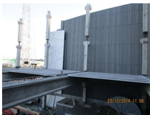
d) Montagem de lajes pré-fabricadas
