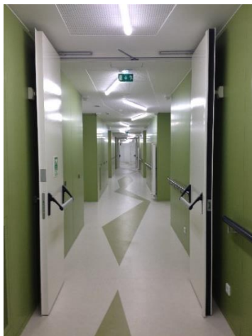
a) Portas CF antes do alarme
