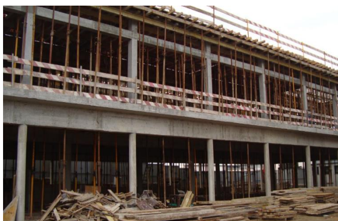
Figura 5.54 – Estrutura de betão do edifício A
