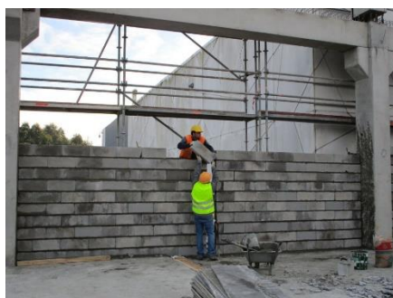
a) Execução de paredes exteriores
