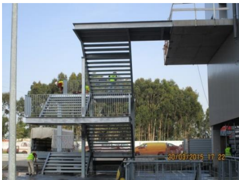
a) Montagem das vias verticais de evacuação 1
