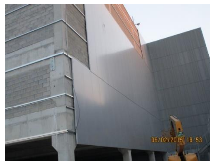
b) Montagem dos painéis da fachada
