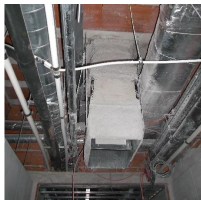
b) Conduta com argamassas projetadas
