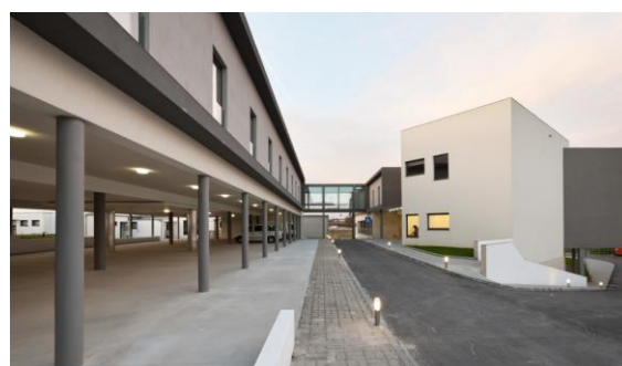
d) Exterior do edifício
