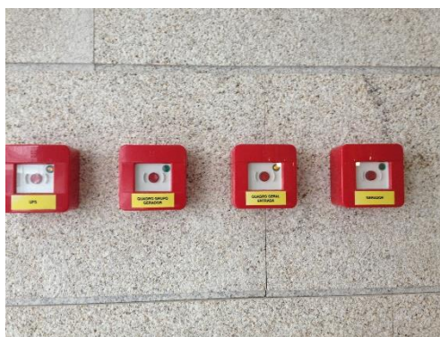
Figura 5.58 – Corte geral da UPS, do quadro do grupo gerador, do quadro geral da entrada e do gerador
