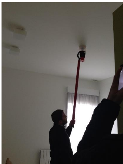
a) Ensaio de detetor do teto falso num dos quartos do piso 1
