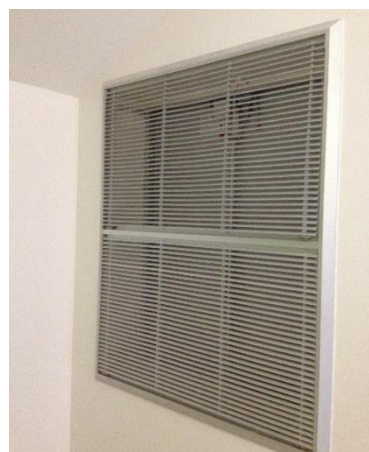
b) Grelha na fachada
