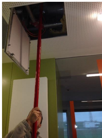
b) Ensaio de detetor do teto real no corredor do piso 0, através de alçapão
