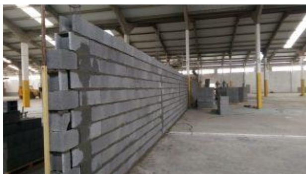
a) Construção da parede com blocos de betão
