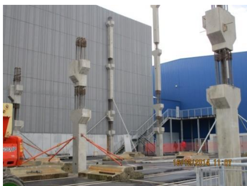
a) Montagem de pilares pré-fabricados
