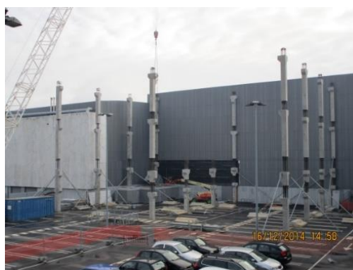
b) Montagem de pilares pré-fabricados
