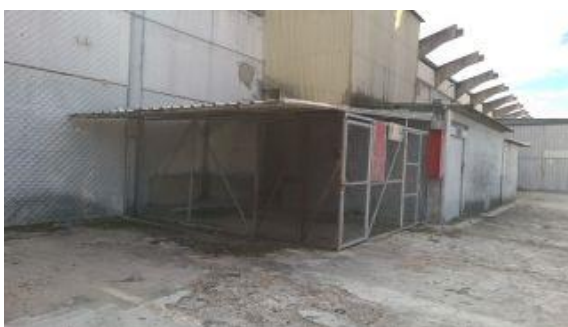
c) Edifício existente
