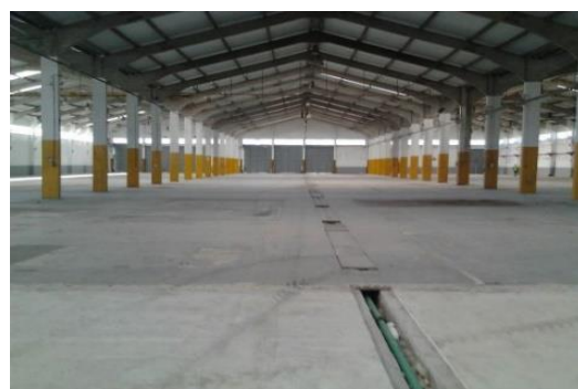
d) Edifício existente
