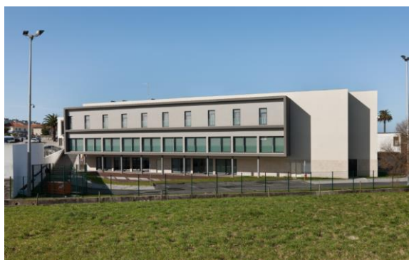
a) Exterior do edifício
