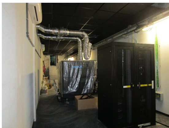
e) Sala de Projeção
