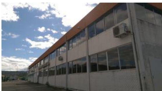
a) Edifício existente
