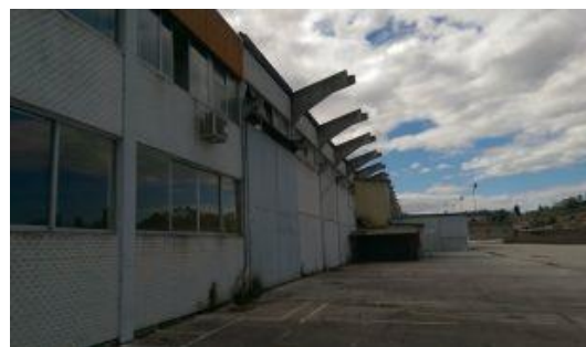
b) Edifício existente
