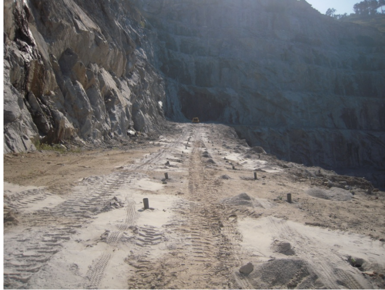
Figura 86. Aspecto da bancada n.º 1 antes da realização do desmonte (pega 2) – Pedreira de Serdedelo.
