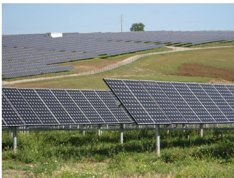
Figura 2.25 - Central Fotovoltaica Hércules [27]
