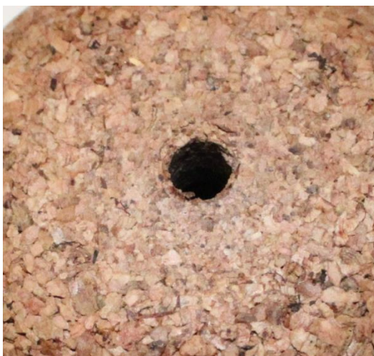
Figura 64 - Elevado grau de compactação verificado no topo da peça.
