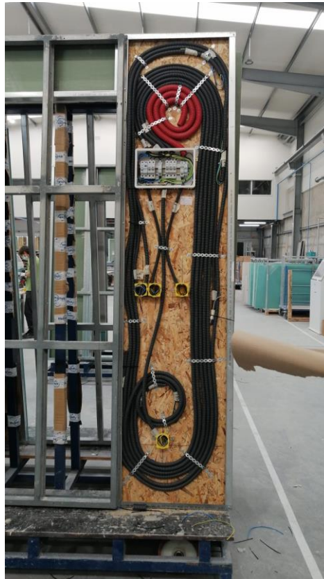
Figura 21 – Parede de WC concluída.
