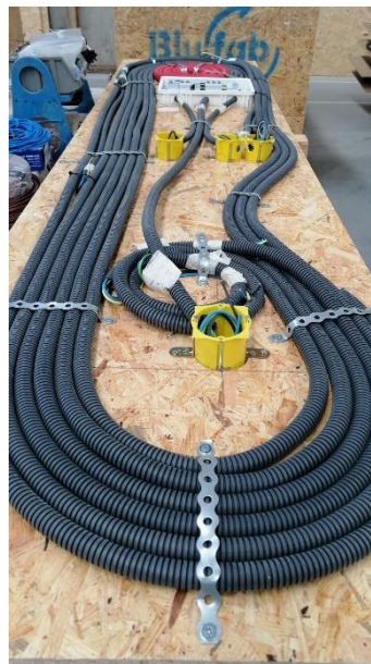
Figura 16 – Parede infraestruturada em fase final de montagem.
