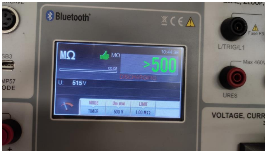
Figura 28 – Equipamento de testes após realização de ensaio de resistência de isolamento.
