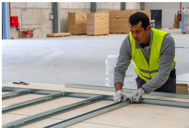
Figura 20 – Processo de estruturação das paredes de um módulo off-site .
