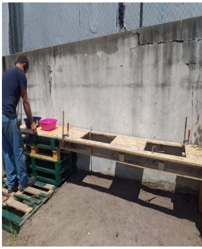
Figura 20- Construção da cozinha de "lama"
