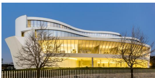
Figura 1 - Edifício do CEiiA (CEiiA 2024)
