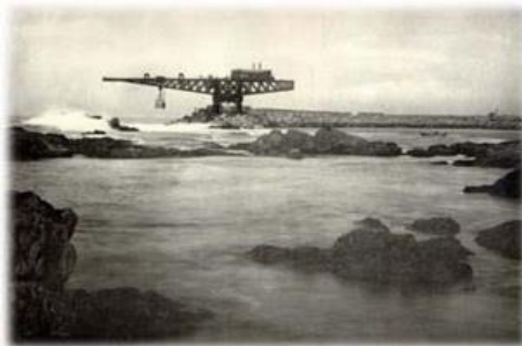
Figura 5. Titã em funcionamento na construção do Porto de Leixões. (Foto de Emílio Biel via arquivo APDL)
