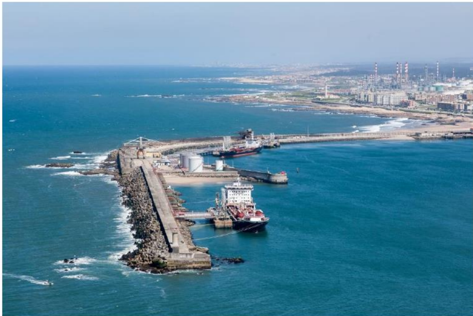
Figura 10 - Quebramar exterior Norte (vista de S-N). Retirado de Nemus, 2017
