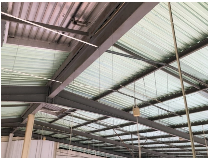
Figura 4-2- Cobertura do edifício
