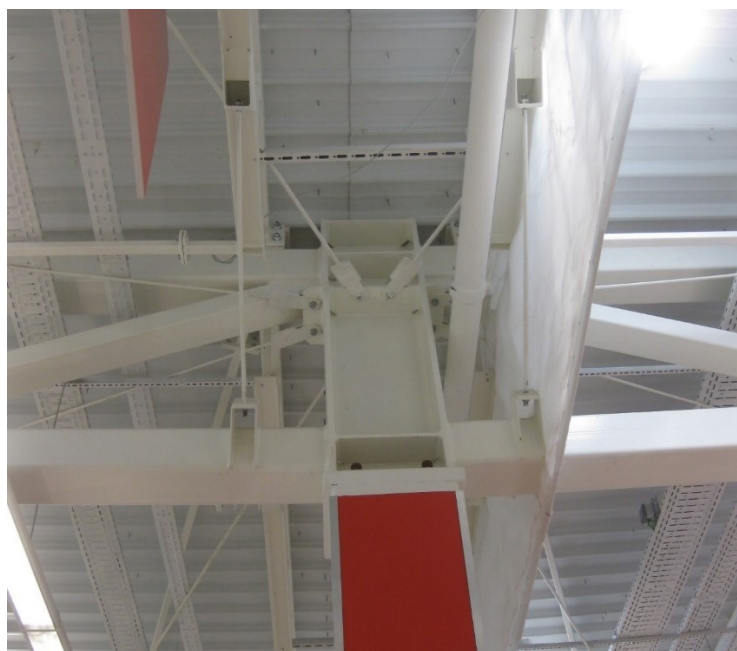
Figura 4-39- Ligação entre asnas consecutivas/ ligação entre asnas e pilares.
