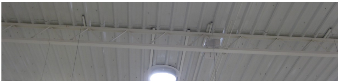
Figura 4-40- Madres da cobertura do edifício.
