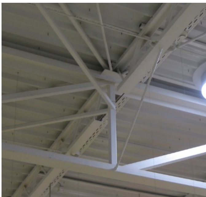
Figura 4-41- Contraventamento do banzo inferior da asna
