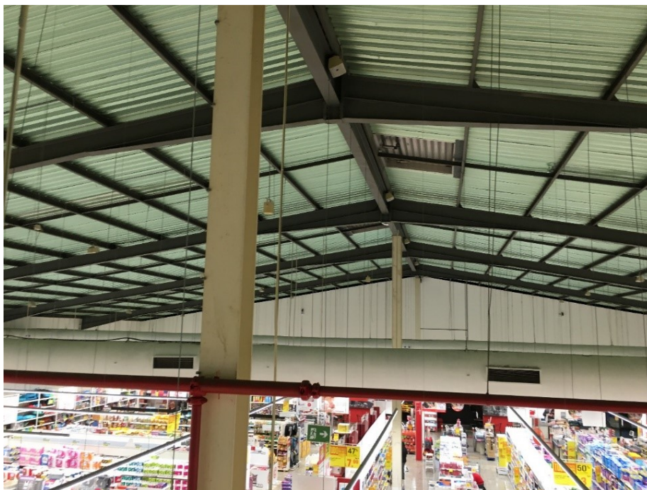
Figura 4-4- Vista dos pórticos metálicos, dos pilares HEB e da viga da cumeeira.
