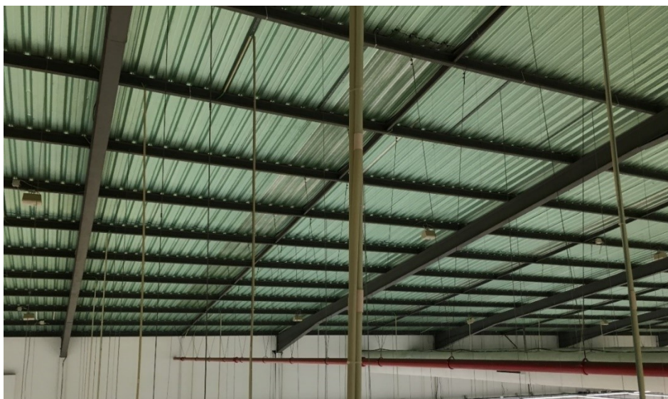
Figura 4-5- Madres da cobertura e respetivos travamentos.
