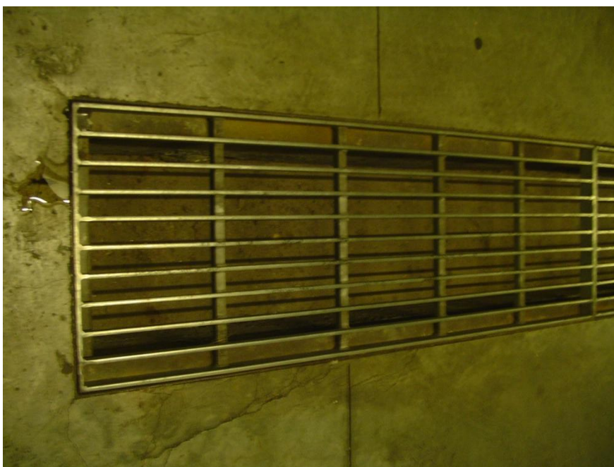
Figura 13 – Caleira de escoamento de águas – Edifício E.
