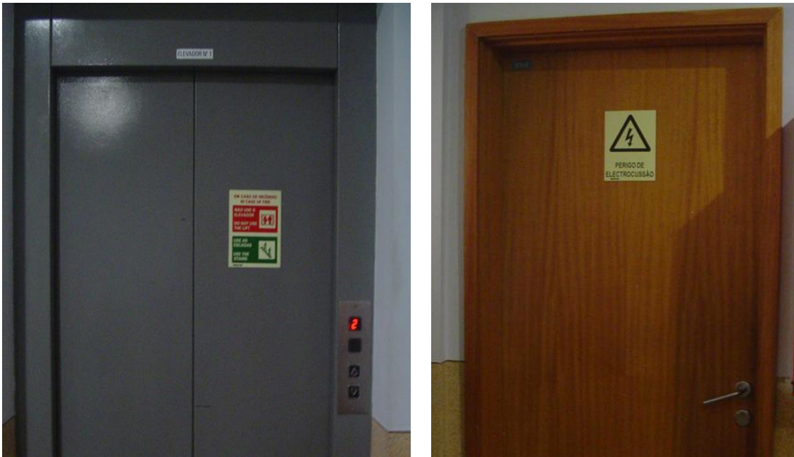
Figura 8- Placas fotoluminescentes de ascensor e perigo de electrocussão.
