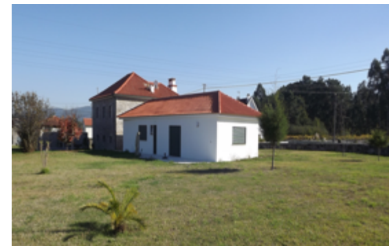
Exterior da casa e jardim
