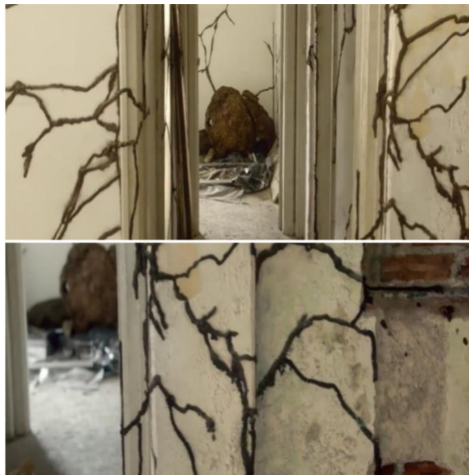
Figura 36 - Imagem do apartamento de cima infestado de cupins
