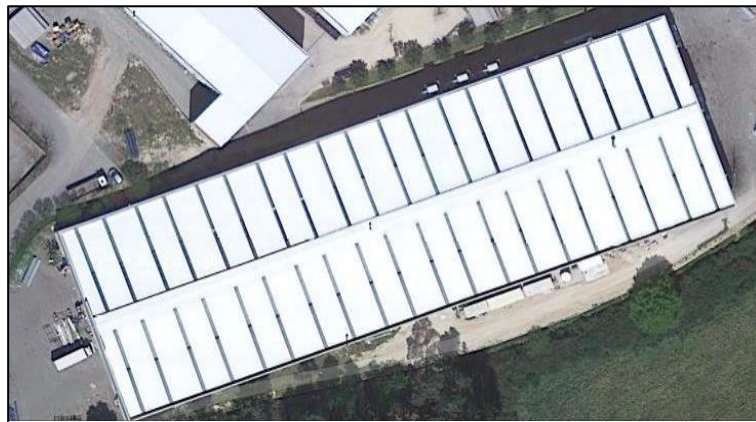
Figura 22 – Telhado do pavilhão 2
