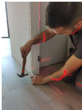
Figura 71 - Montagem de uma porta
