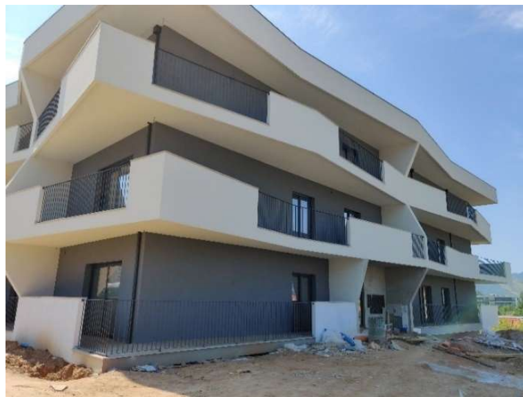
Figura 67 - Exterior do edifício
