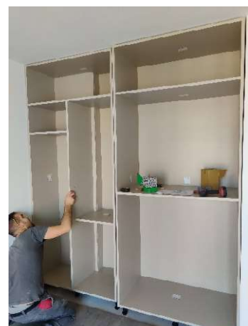
Figura 70 - Montagem de um roupeiro
