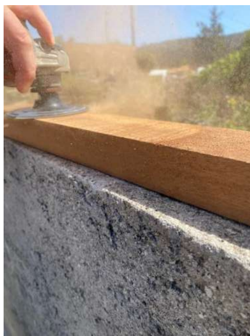
Figura 227 Processo de lixamento bruto.
