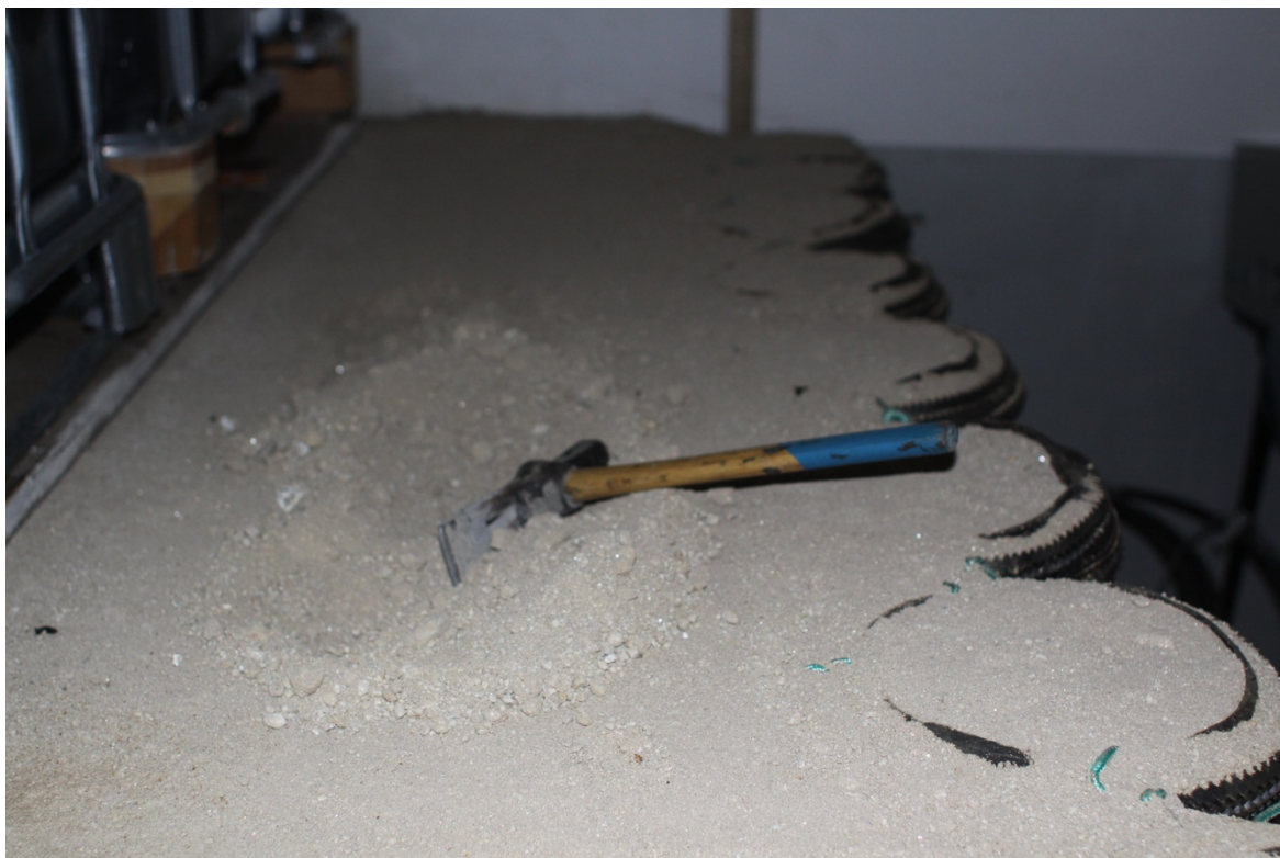
Figura 3.9 – Escavação do solo junto ao paramento.
