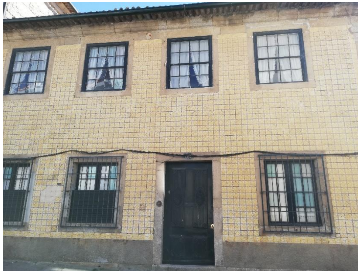
Figura 3.1 – Fachada principal, revestida a azulejo
