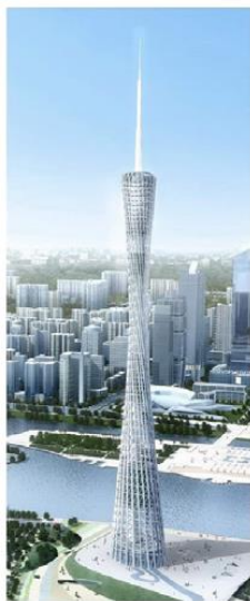
a) Torre de TV New Guangzhou
