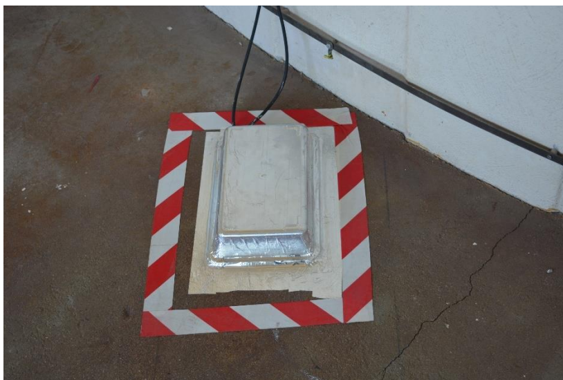
Figura 4.20 - Instalação dos anemômetros da cota 312,65.
