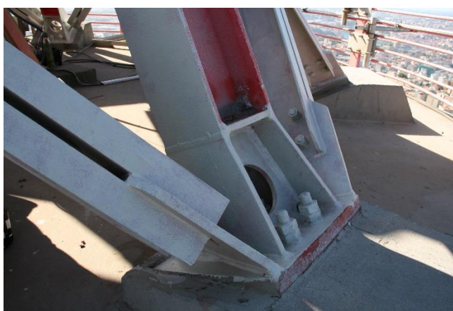
b) Fixação do palito metálico ao fuste de betão.
