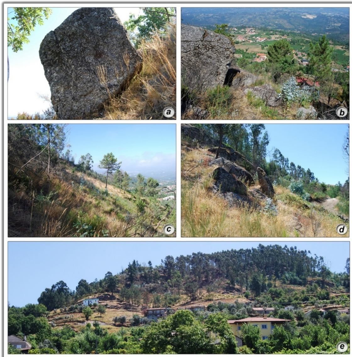
Figura 24. Aspetos gerais da vertente rochosa de S. Simão: a e b – blocos instáveis; c e d – inclinação geral da vertente; e – vista panorâmica da vertente e as habitações no sopé da vertente.
