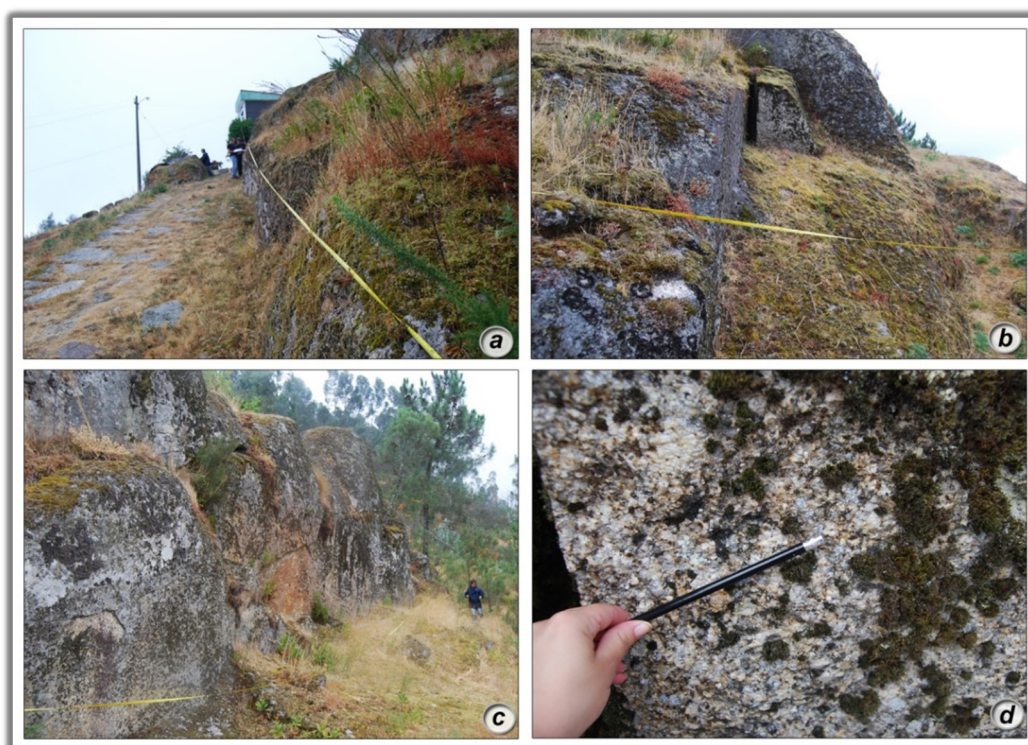
Figura 33. Aspetos gerais do Setor I.
