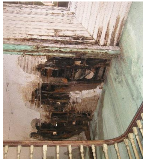
d) Elevado teor de humidade nos elementos de madeira de suporte de teto.
