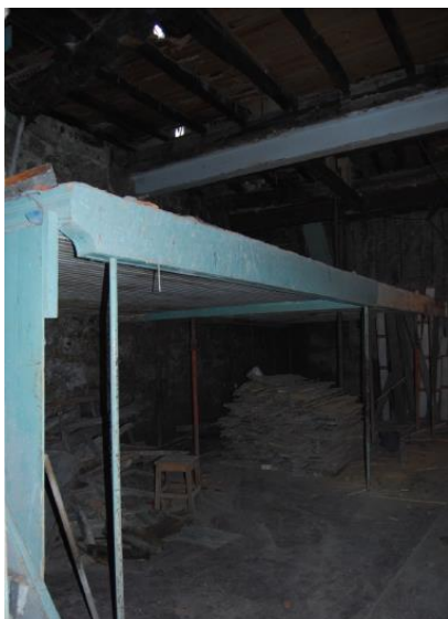
Figura 17 - Plataforma de trabalhos.
