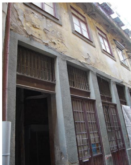
Figura 15 – Fachada do edifício.
