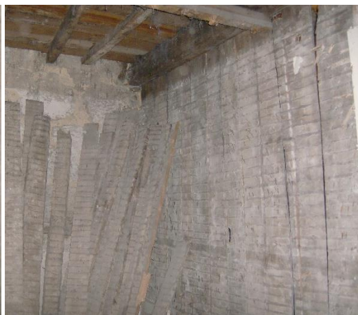
Figura 20 - Paredes interiores de tabique.
