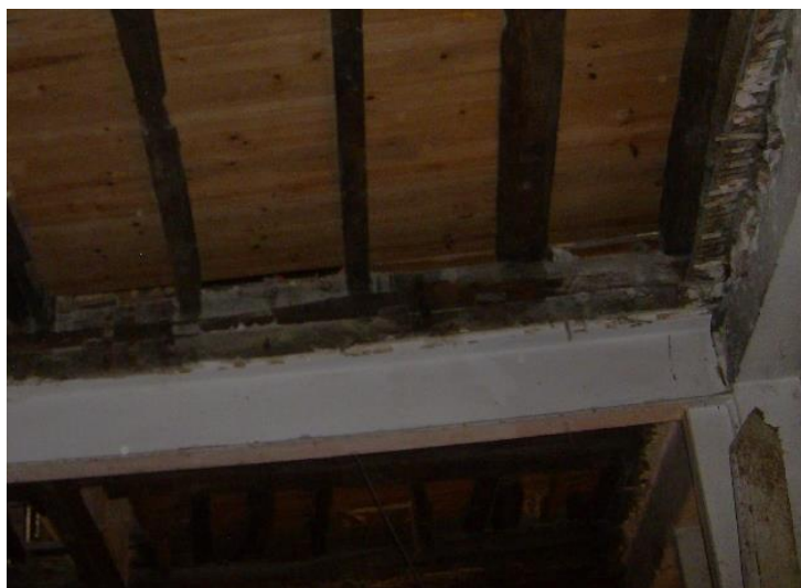
Figura 16 – Vigas e Pilares de escoramento do pavimento.
