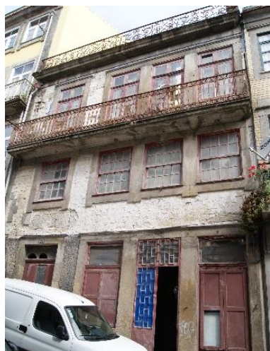
Figura 21 – Fachada do edifício.
