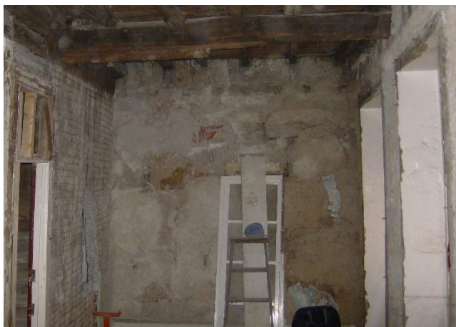
Figura 19 - Paredes de empena em alvenaria de pedra.
