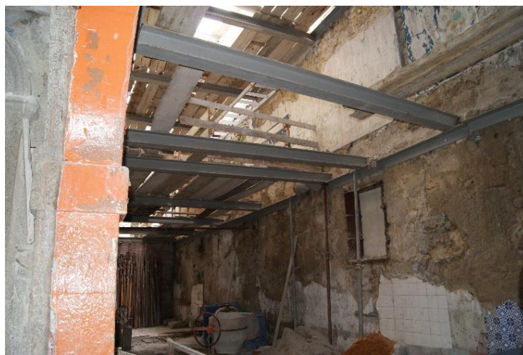
Figura 22 – Estrutura de escoramento das paredes exteriores.
