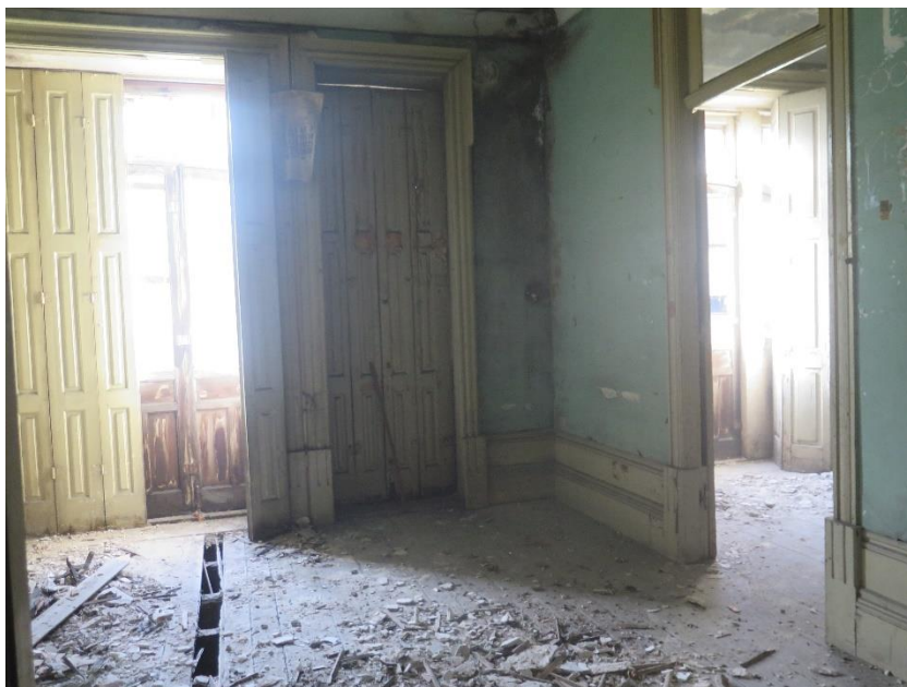
Figura 3.3 - Fração de habitação antes de ser alvo de reabilitação
