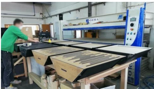
Figura 38 - Instalação painel frontal
