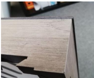
Figura 43 - Erro de posicionamento do painel frontal
