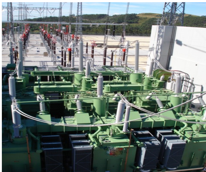
Figura 5 – PST da RNT, tipo “ quadrature booster ” em duas cubas. (Fonte: REN)
