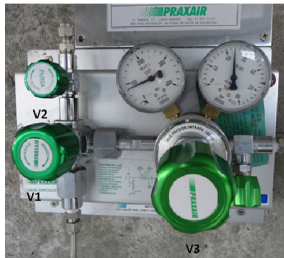
Figura 70- Quadro de acionamento do compressor
