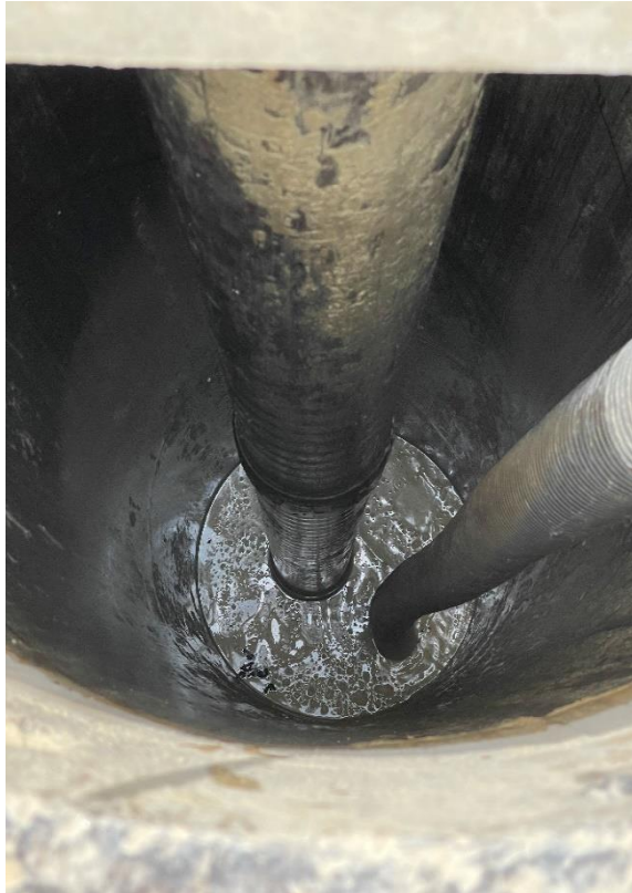
Figura 25 – Colocação de tubos trémie e polímero.
