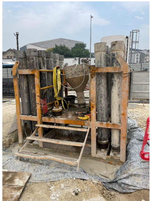
Figura 24 – Armazenamento de tubos trémie.
