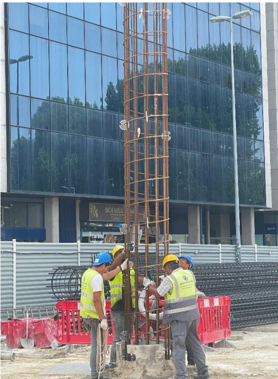
Figura 23 – Colocação minuciosa da armadura.
