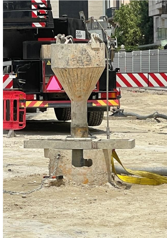
Figura 26 – Colocação de tubos trémie numa estaca.
