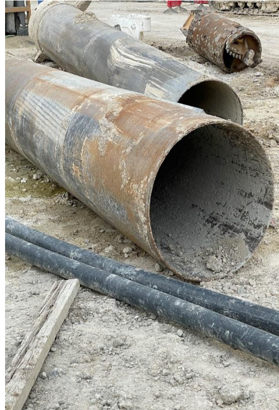
Figura 18 – Exemplos de tubos moldadores de parede simples utilizado.
