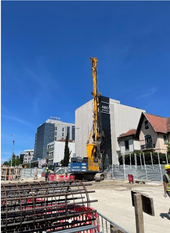
Figura 17 – Exemplo de equipamento de perfuração BG 28.
