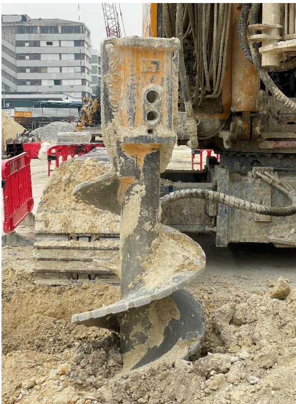
Figura 19 – Ferramenta de corte trado curto.
