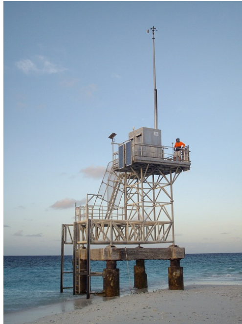
Figura 2.7: Estação Meteorológica numa torre [23].
