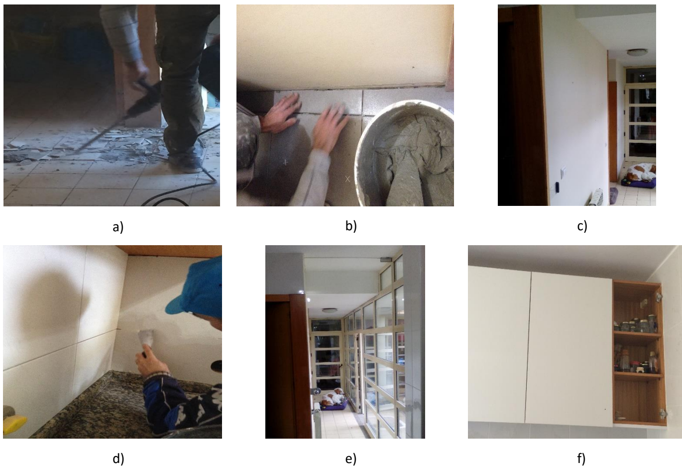
Figura 2.7 – Conjunto de fotografias das tarefas acompanhadas na obra
