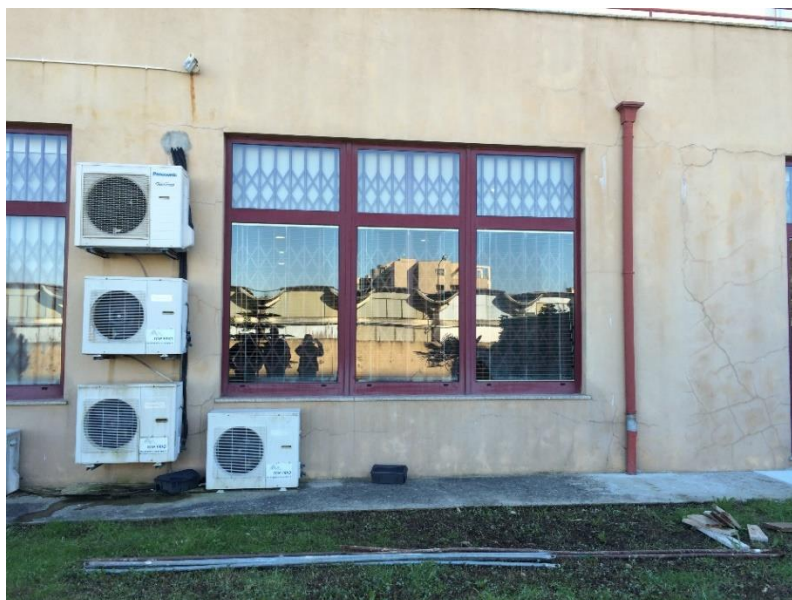
Figura 2.9 – Estado inicial da fachada
