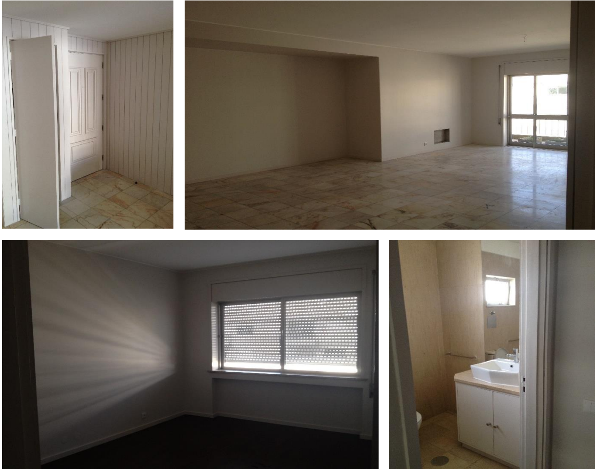
Figura 2.15 – Estado final da obra
