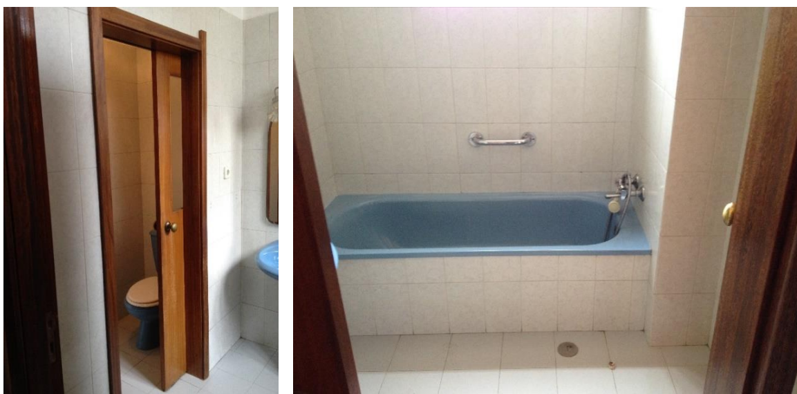
Figura 2.16 – Estado inicial da casa de banho
