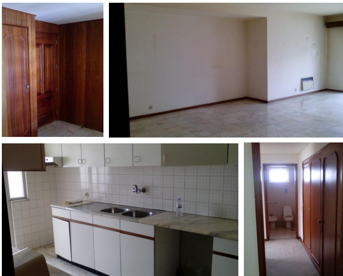
Figura 2.13 – Estado inicial da obra
