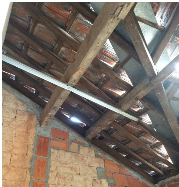
Figura 4.10 – Reforço da estrutura da cobertura inclinada
