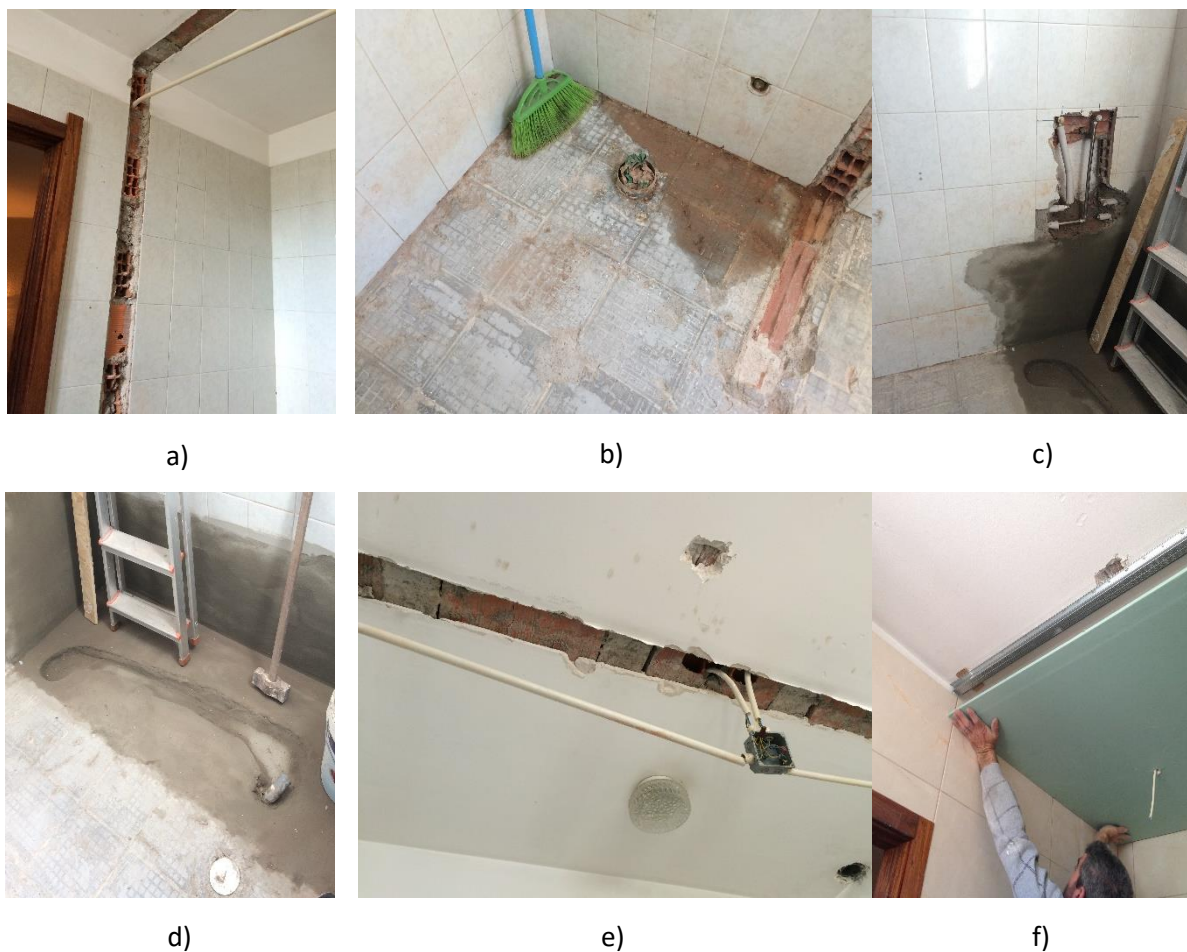
Figura 2.17 – Conjunto de fotografias das tarefas acompanhadas na obra
