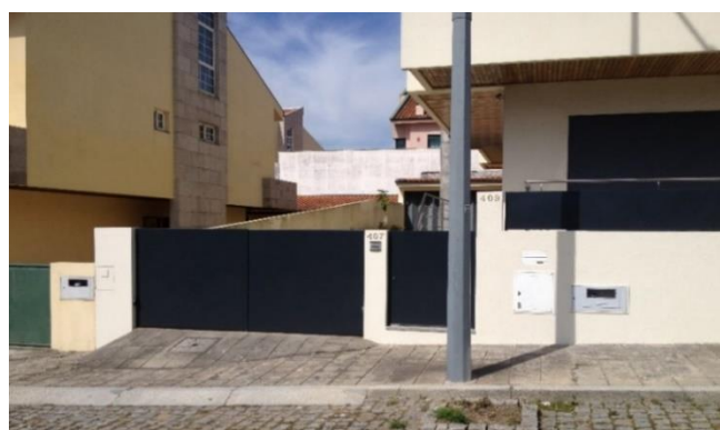
Figura 2.26 – Estado final da fachada
