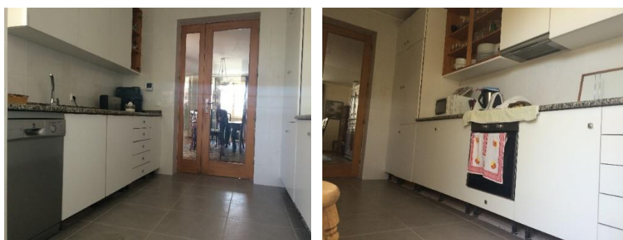
Figura 2.8 – Estado final da cozinha
