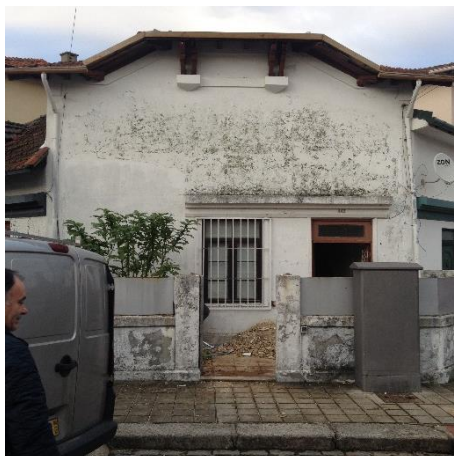
Figura 4.7 – Fachada sudoeste da moradia em estudo
