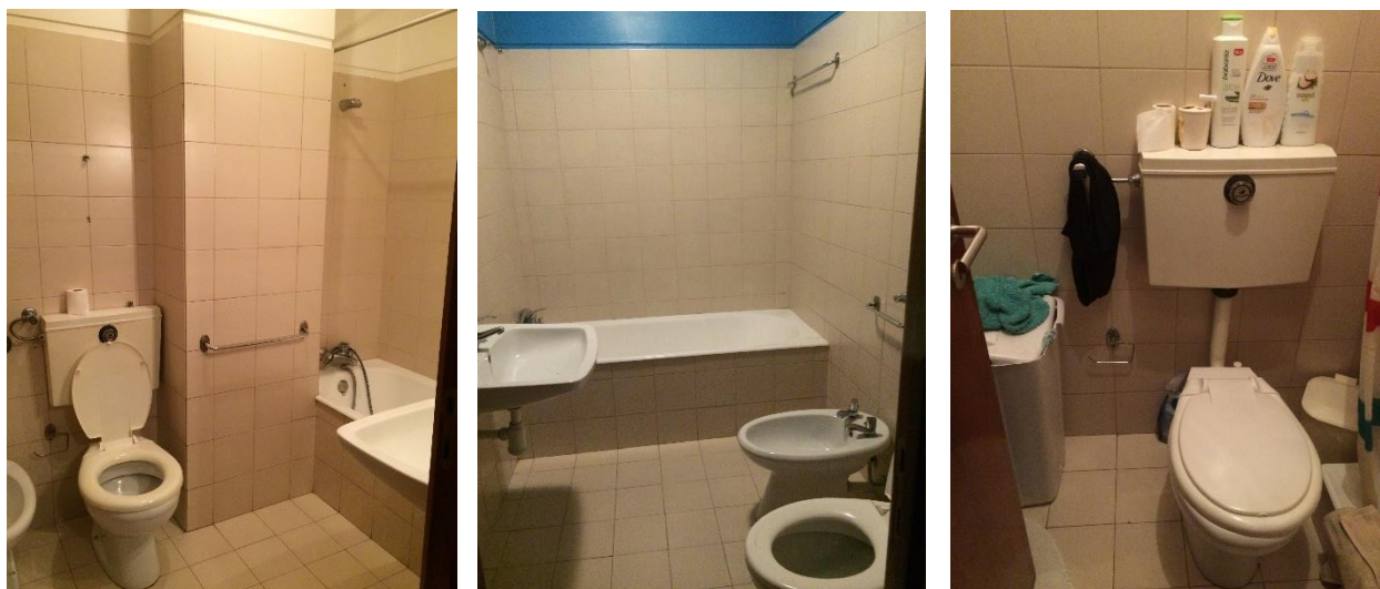
Figura 2.27 – Estado inicial de três das quatro casas de banho
