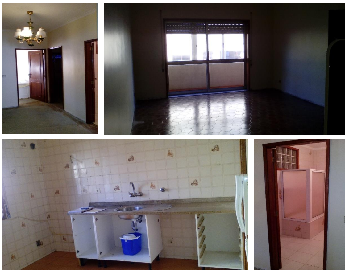
Figura 2.11 – Estado inicial da obra
