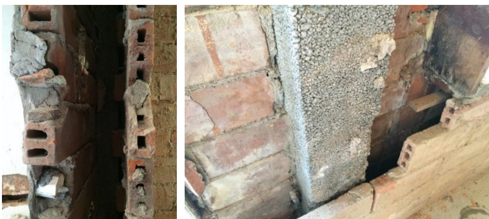
Figura 4.8 – Estado inicial das paredes em contacto com o exterior
