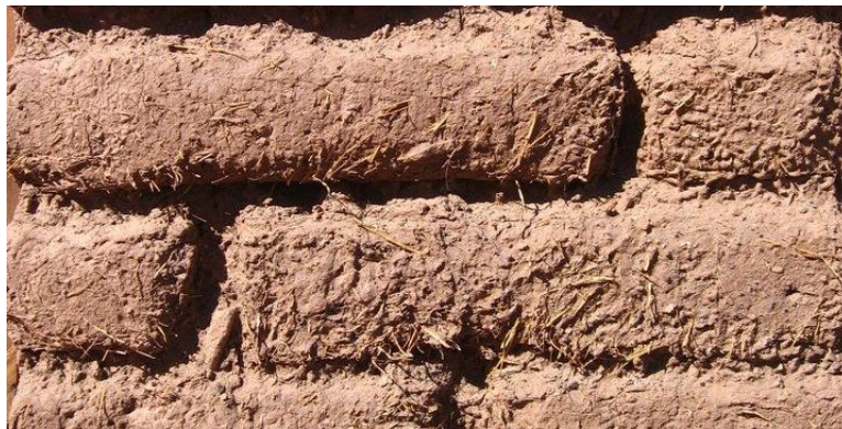
Figura 21 - Tijolos de argila reforçados com palha.
