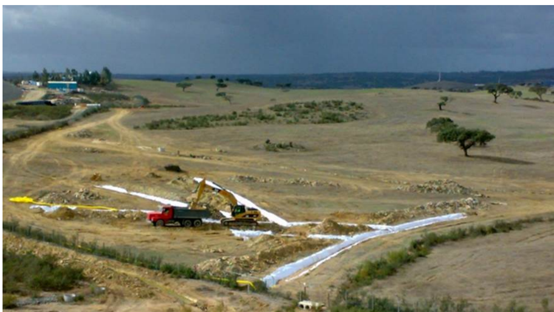
Figura 66 – Construção das valas de drenagem coletadas pelo IBR34.
