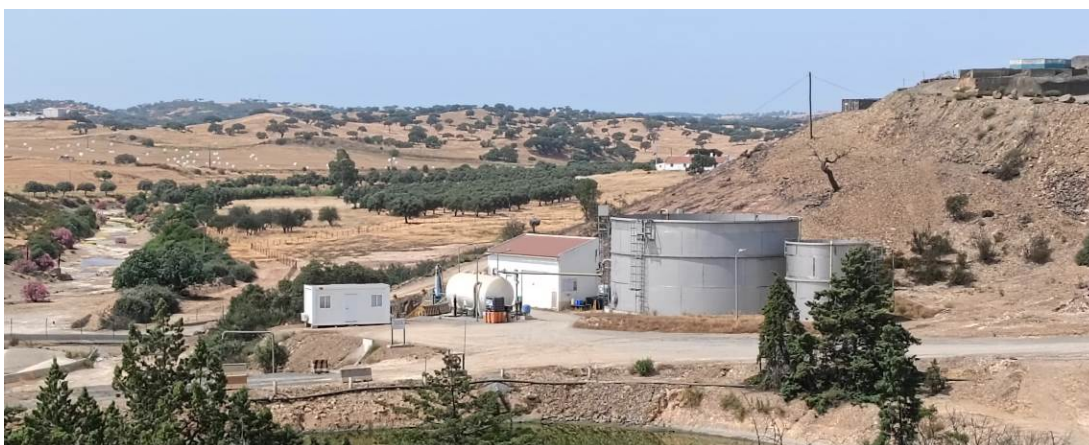
Figura 58 – Vista geral da ETARD.
