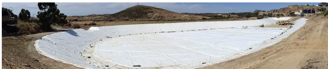
Figura 56 – Impermeabilização da BAC 4.
