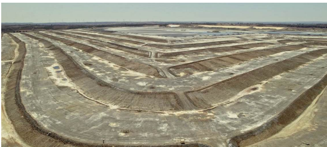
Figura 21 – Instalação de Resíduos do Cerro do Lobo (fonte: vídeo institucional Somincor).
