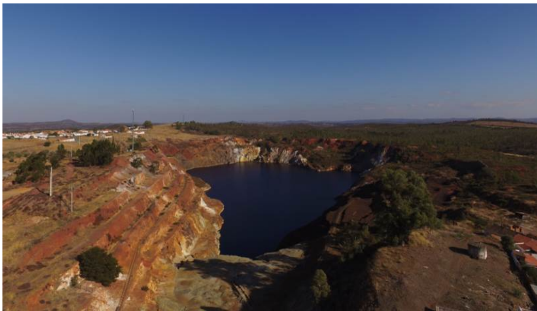
Figura 8 – Corta de São Domingos (fonte: Recuperação Ambiental da Área Mineira de São Domingos - EDM
