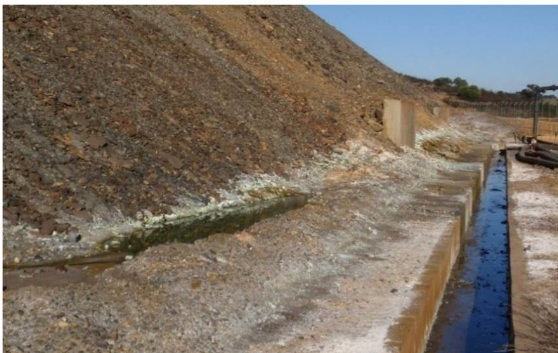
Figura 86 – Pé de talude da escombreira.
