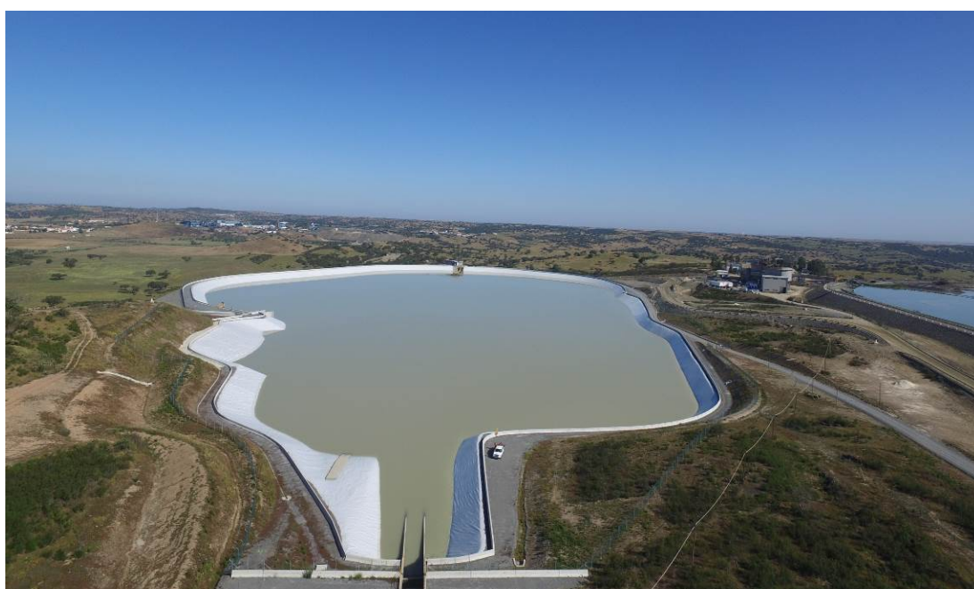
Figura 47 – Reservatório do Cerro da Mina - Água Industrial.
