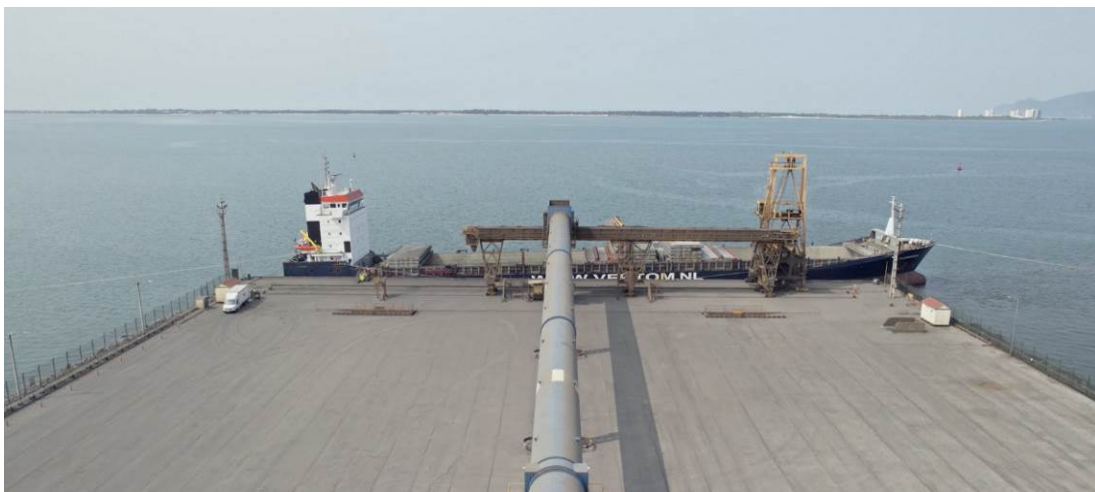
Figura 20 – Instalação da Somincor no Porto de Setúbal (fonte: vídeo institucional Somincor).
