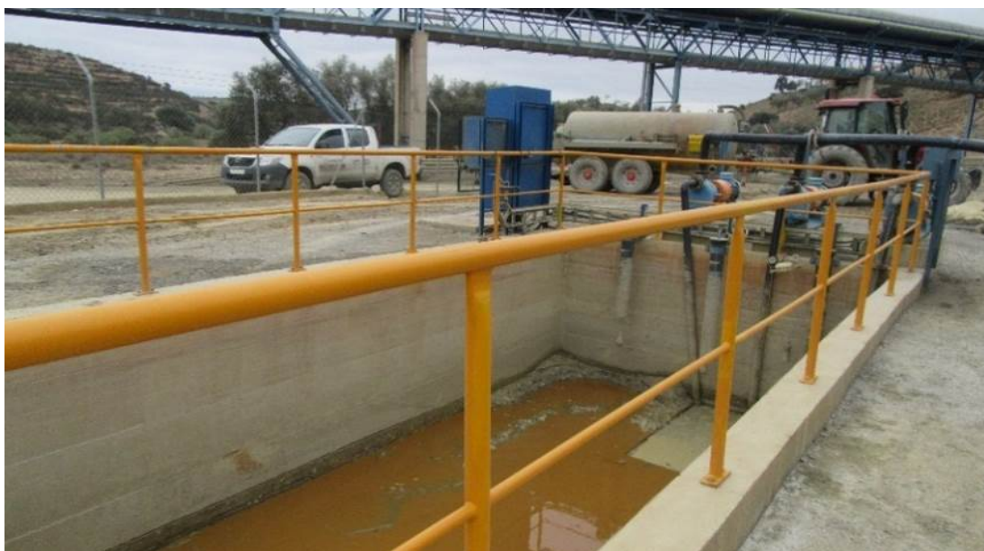
Figura 87 – Tanque da escombreira.
