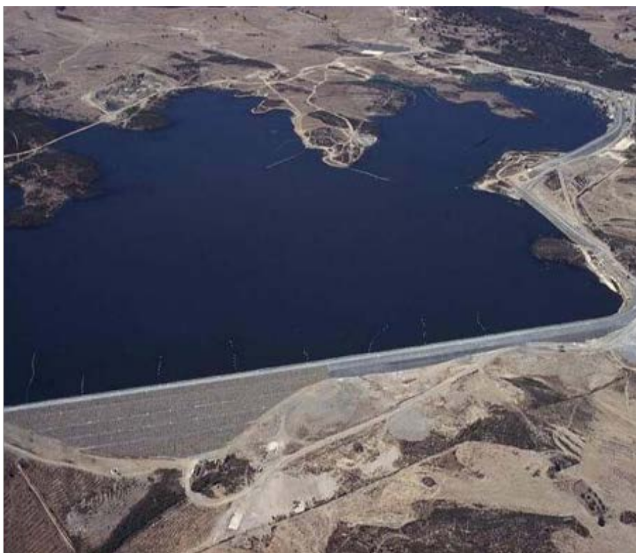
Figura 50 – Instalação de Resíduos do Cerro do Lobo em 2005 (fonte: https://waterhub.pt/pt/projects/barragem-do-cerro-do-lobo ).
