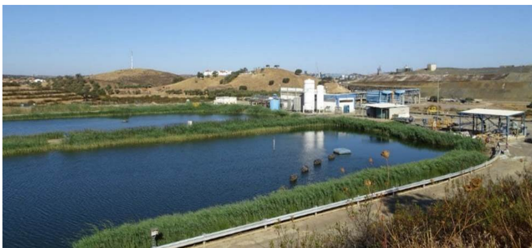
Figura 60 – Vista geral da ETAM.
