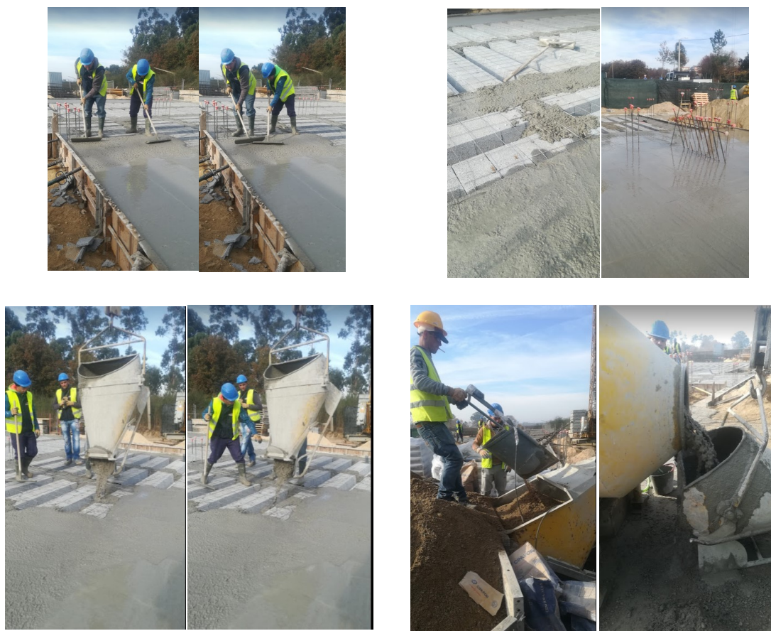
Figura 20: Fotografias do Processo de Betonagem - empresa A.
