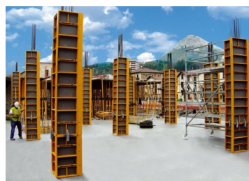
Tipo de cofragem (pilar)
