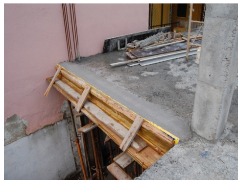
Figura 10: Exemplos de Descofragem.
