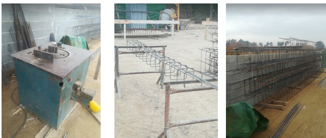
Figura 19: Fotografias da Fase de Armação de Ferro - empresa A.
