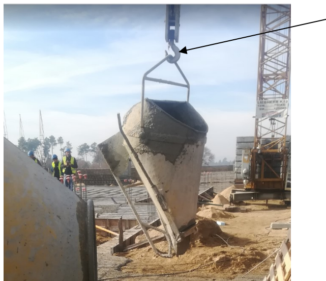
Figura 21: Fotografia Gancho com patilha partida.
