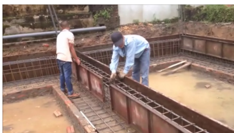
Tipo de cofragem (viga)
