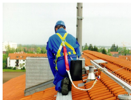
Figura 12: Trabalhos na Cobertura.
