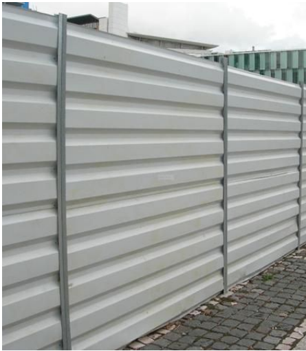
Vedação em tapume metálico
