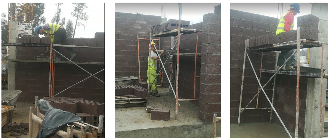
Figura 22: Fotografias da Fase de Alvenaria no Exterior.
