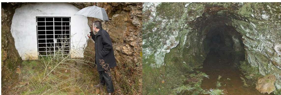
Figuras 16,17, 18 e 19 – Acesso à galeria que acreditava ser a melhor opção, figura 16. Figuras 17 e 18, Jorge Morais serve de escala, para assim se compreender a envergadura da entrada da galeria bloqueada. Figura 19, visão possível da galeria através das grades. (fotografias: António Morais)
