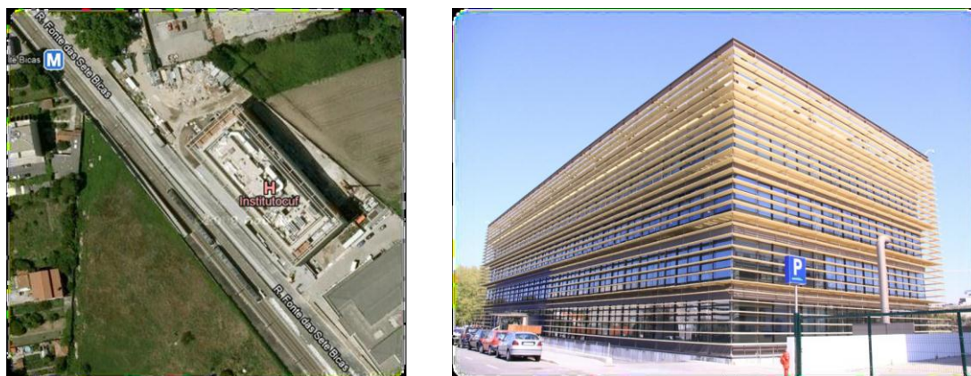
Figura 3.1: Localização, Hospital da ICUF Fonte: (EDP, 2012)
