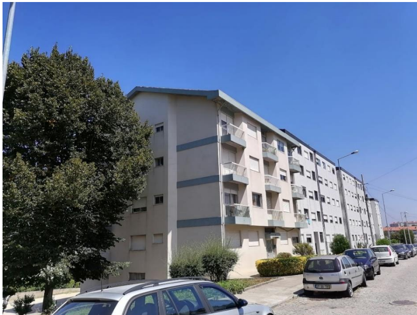
Figura 38 – Edifício de Estudo
