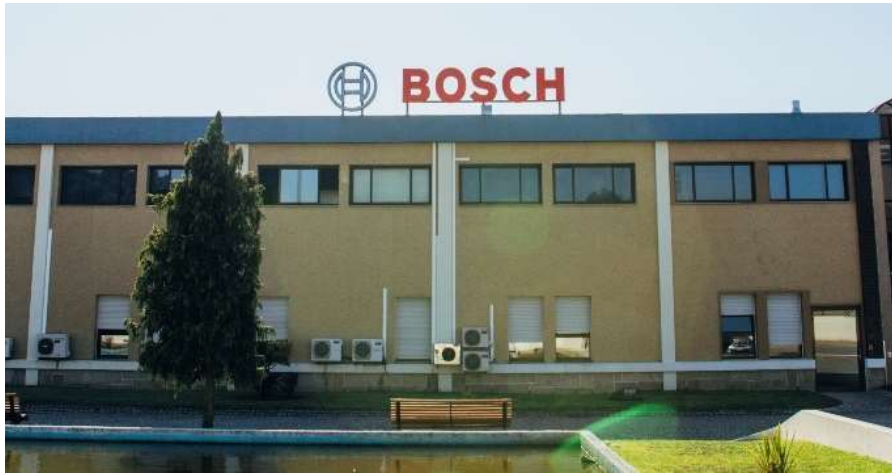
Figura 13: Instalações Bosch Building Technologies em Ovar
