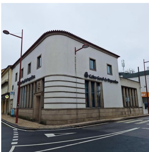
Figura 7 - Edifício CGD Estarreja. Fonte: Própria
