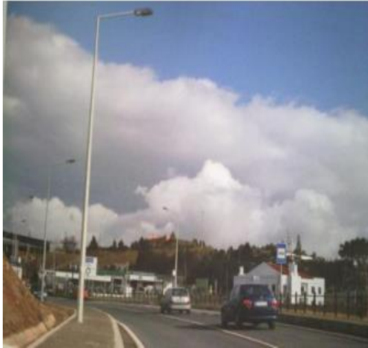
Figura 24 - Solução lateral com colunas octogonais com colunas de 10 m de 150 w com luminária Sintra e um ponto de luz de 4 pontos.
