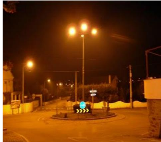
Figura 24 - Solução lateral com colunas octogonais com colunas de 10 m de 150 w com luminária Sintra e um ponto de luz de 4 pontos.
