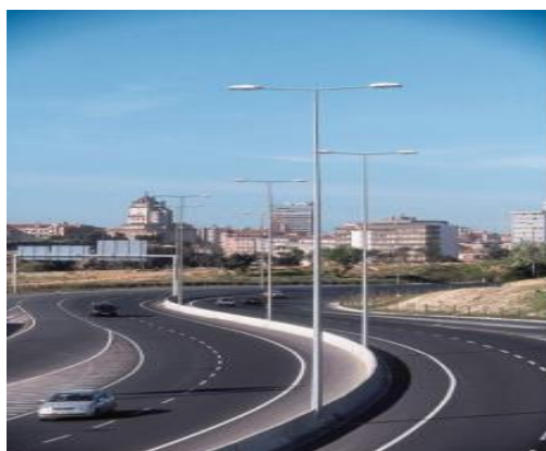
Figura 23 - solução de iluminação central coluna octogonal 12 m de sodio 150 w com luminárias Onix,
