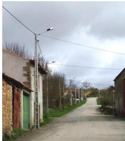
Figura 27 - solução aérea com solução de 70 w sódio Ródio rural
