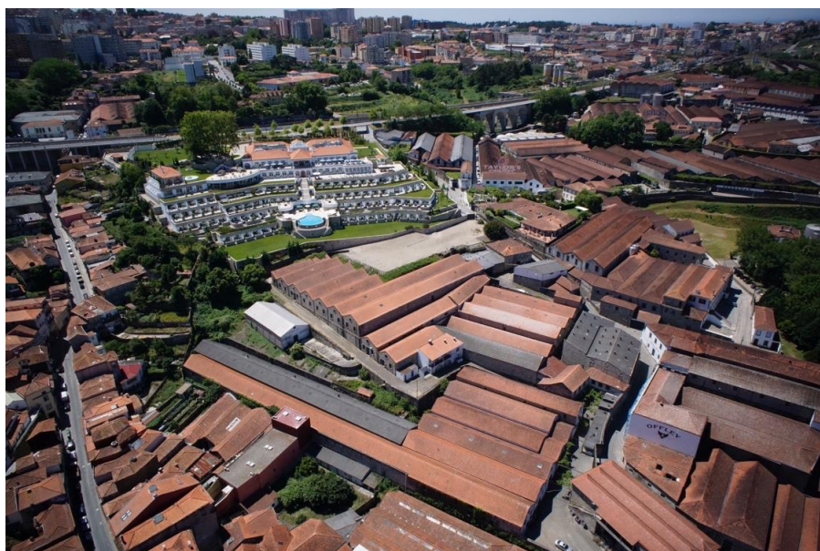
Figura 28 : Antes do início das obras para o complexo “WOW” – Junho 2017
