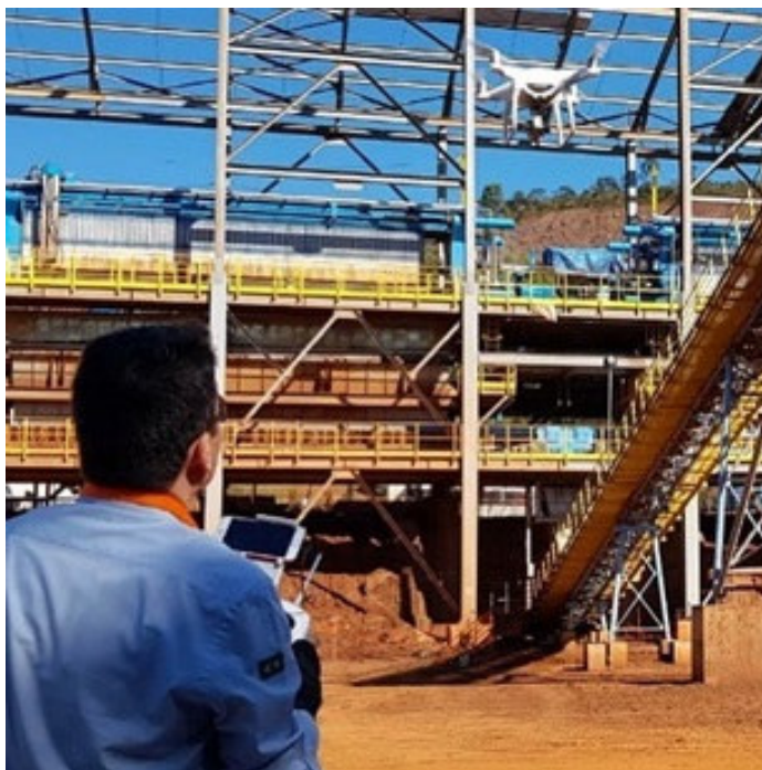
Figura 2-25 – Inspeção de obra na fase de construção com UAV (Salleto, 2021)
