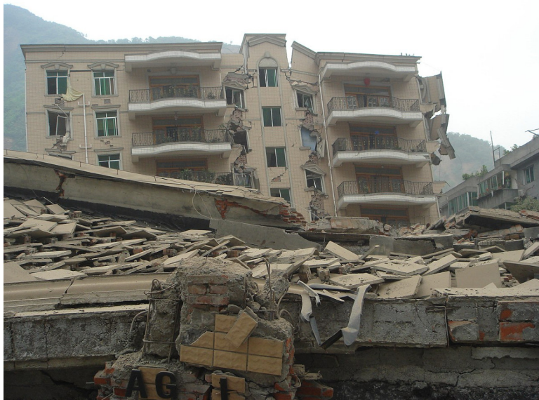
Figura 2-20 - Fissuras e Colapso de Estruturas devido à Ações Sísmicas (ADBC, 2018)
