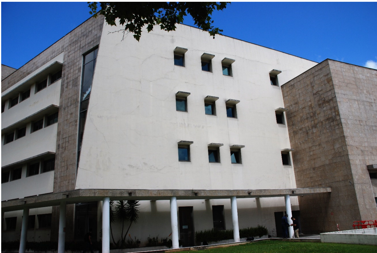
Figura 6-2 – Fachada do Edifício F alvo do ensaio
