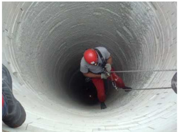
b) Alpinismo Industrial (Pissutti, 2010)
