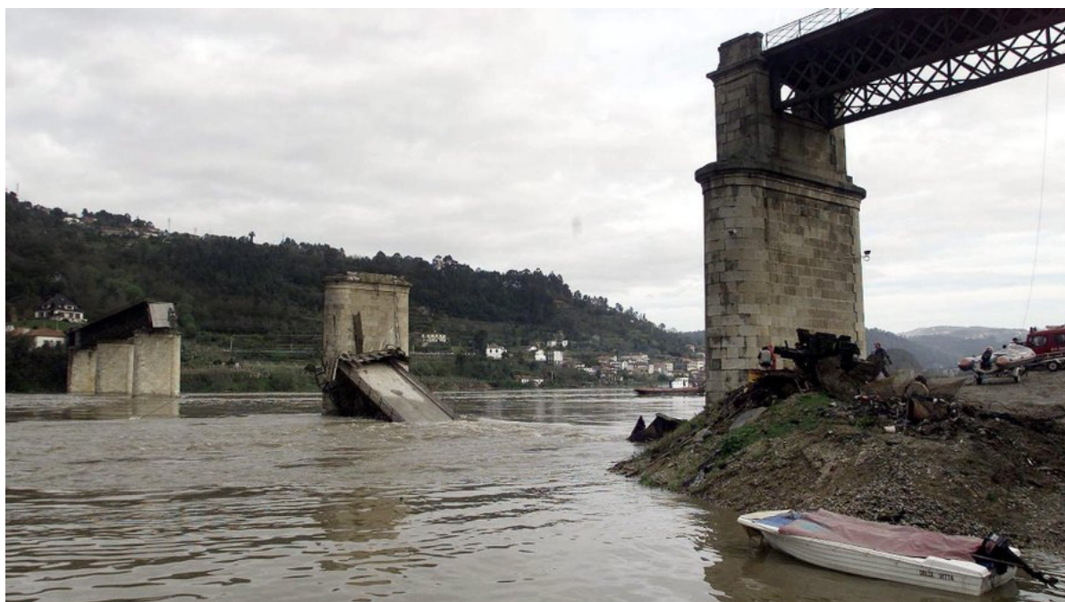
Figura 2-21 – Colapso da Ponte Hintze Ribeiro (Observador, 2021)
