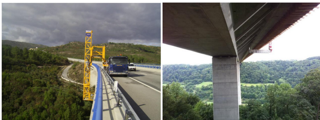
Figura 1-1 - Plataforma Bybridge Autopropulsionada (BridgeByBridge, 2021)
