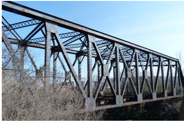
Figura 15 – Ponte com estrutura treliçada[24]
