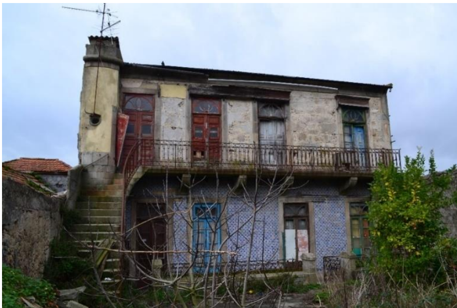
Figura 2.3 - Fachada em pedra, revestida a reboco e material cerâmico
