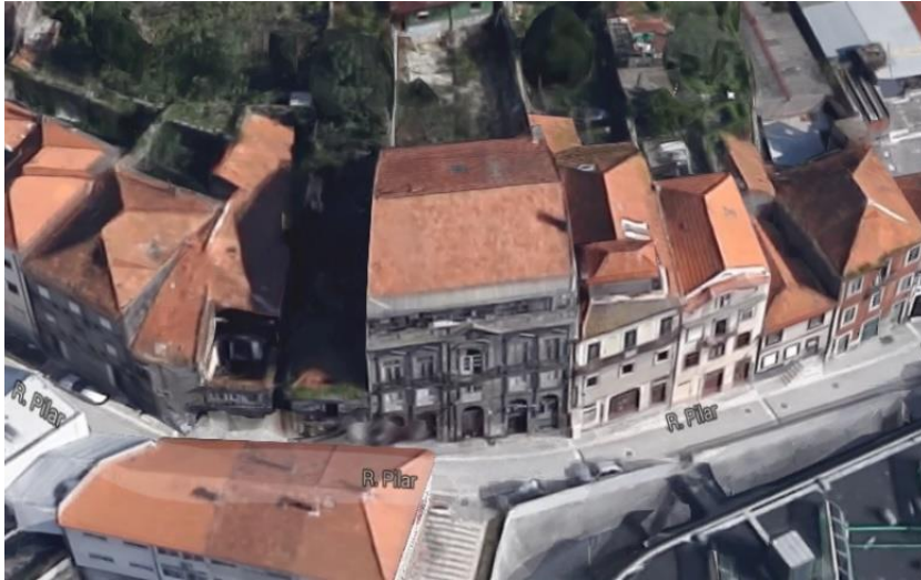
Figura 3.8 - Cobertura do edifício [11]
