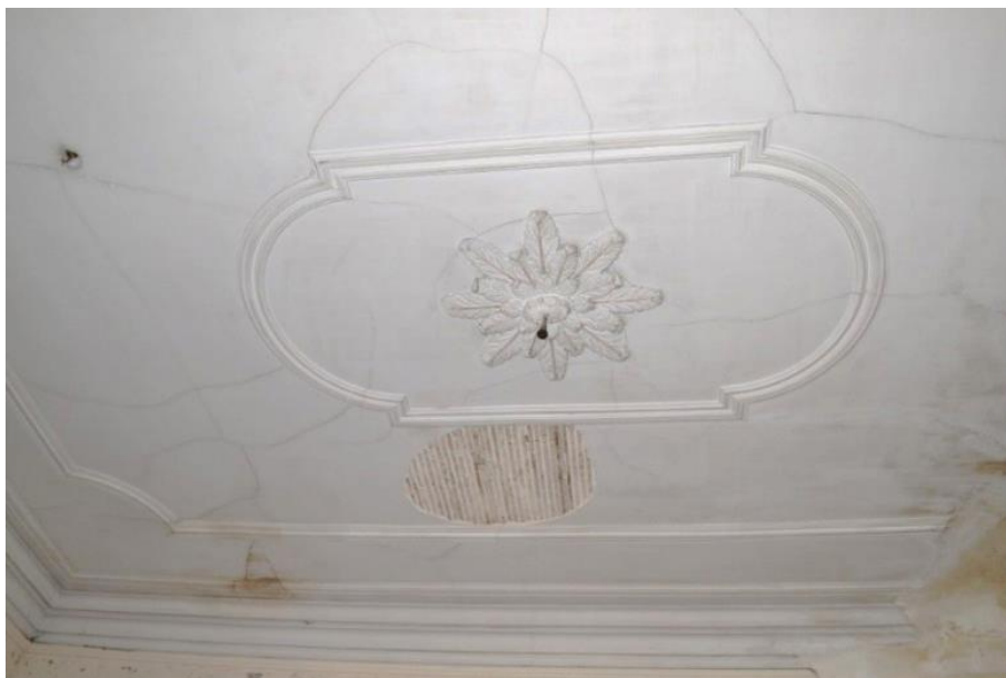
Figura 2.10 - Teto fasquiado com ornamentações em gesso
