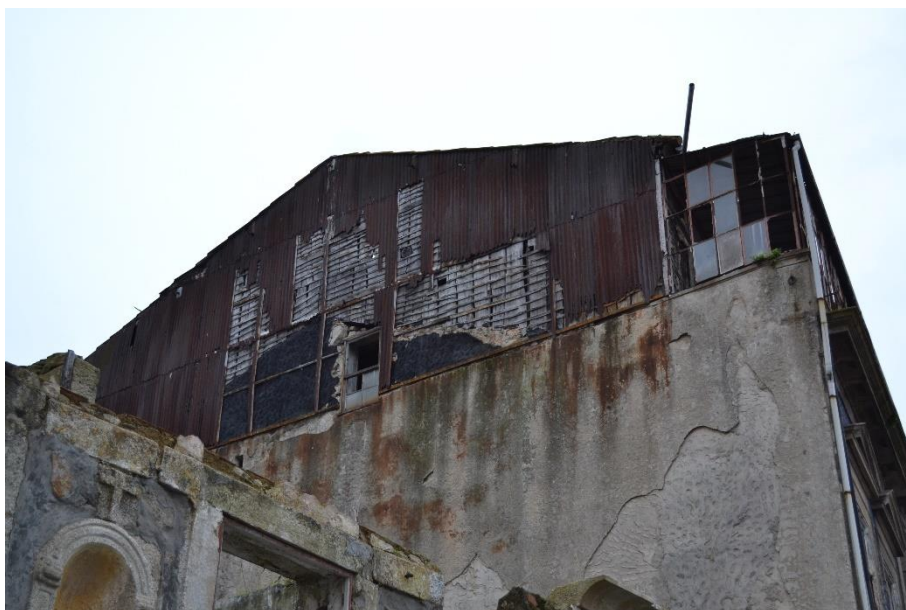
Figura 3.6 - Parede da empena Norte
