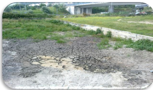
Figura 8.3 Resíduo no final do tratamento
